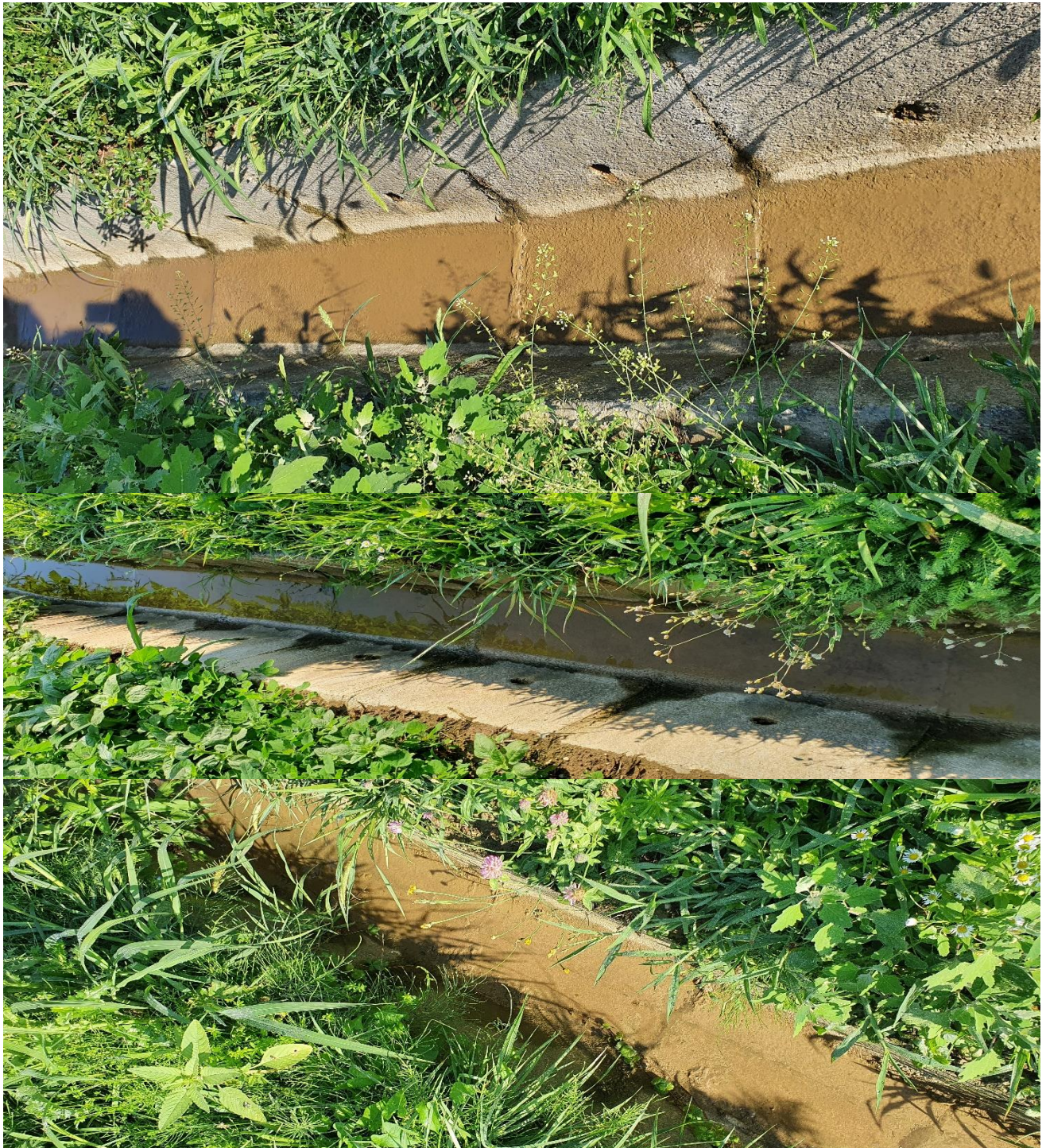
Stanje obodnog kanala oko tijela odlagališta – 26.07.2020.
