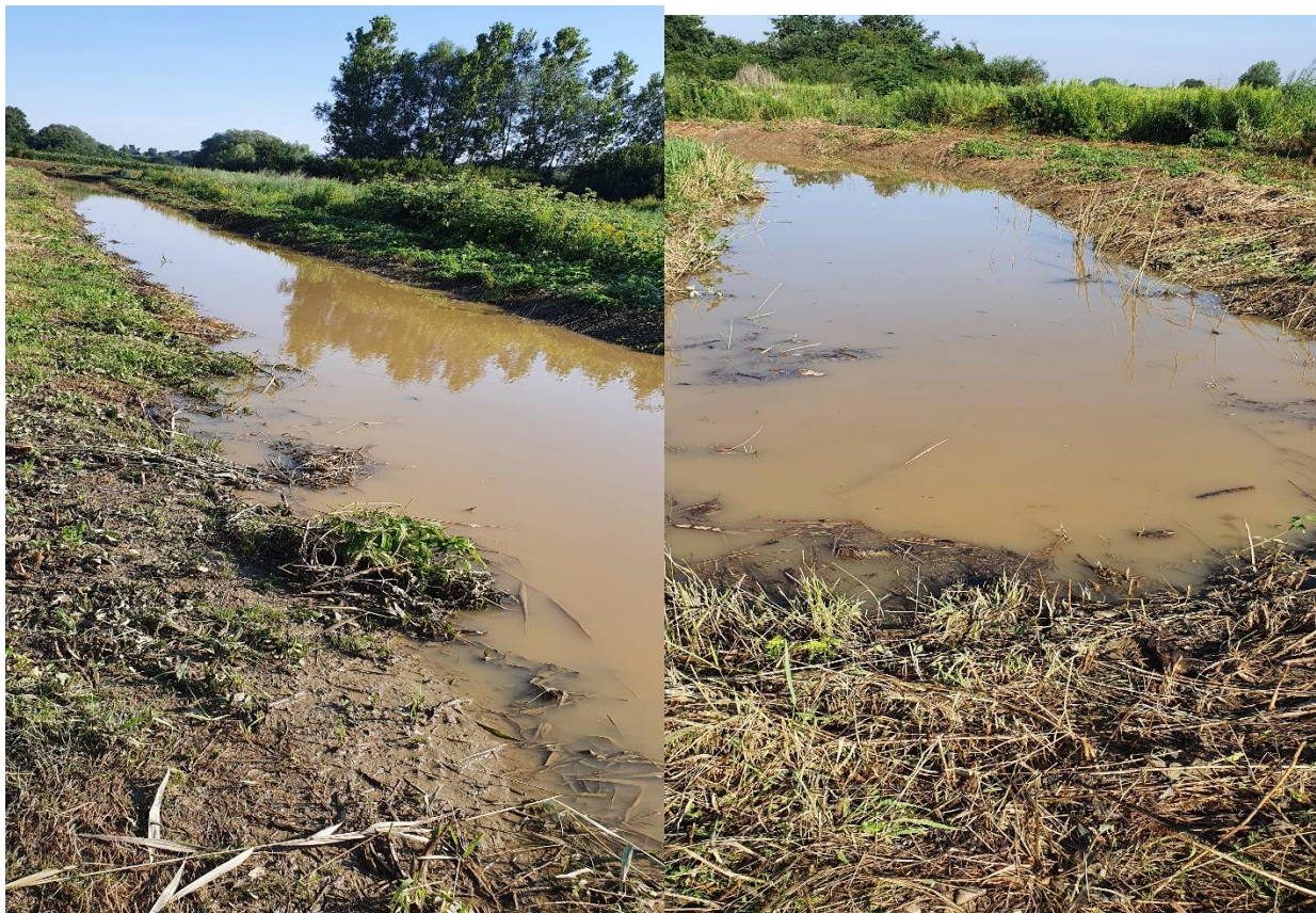
Stanje odvodnog kanal oborinskih voda prema potoku Gliboki 26.07.2020.
