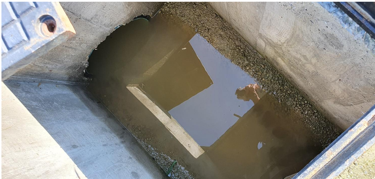
Stanje okna sa zapornicom neposredno prije ispusta u odvodni kanal – 26.07.2020.
