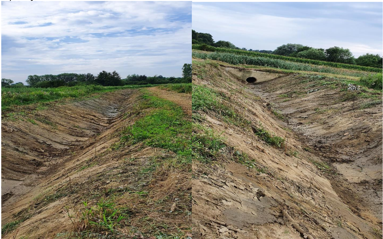
Odvodni kanal oborinskih voda sa odlagališta Piškornica prema potoku Gliboki – 24.07.2020.
